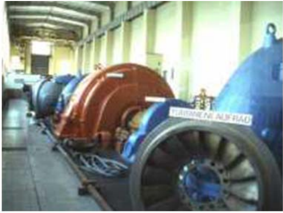
Die alte Turbinenhalle, heute ein Museum
