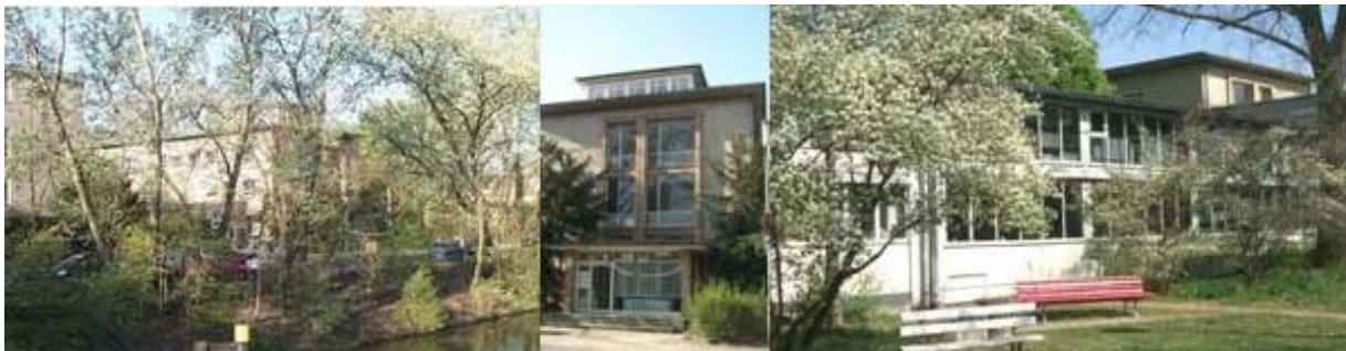
Bild 4: Ansichten des Hermann-Föttinger-Gebäudes
