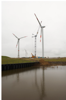
Aufbau der ersten Windkraftanlage mit Voith Windrive® im Dezember 2006
