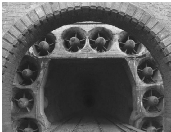
Bild 6: Nordportal des Kaiser-Wilhelm-Tunnels [2]
